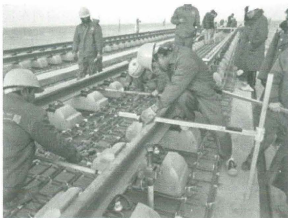
说明图 9.2.6—1 采用 L 道尺进行轨排粗调示意图
