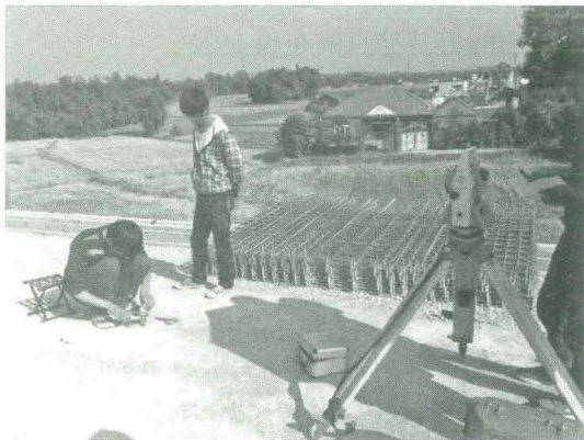
说明图 9.2.1—1 全站仪放样模板边线
